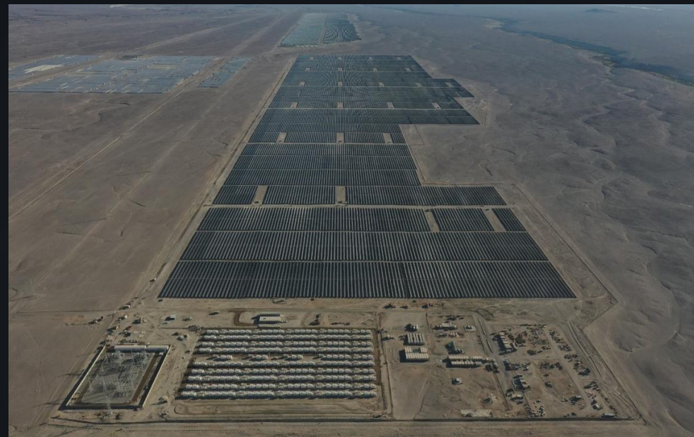
Planta fotovoltaica y BESS de utility scale en construcción
